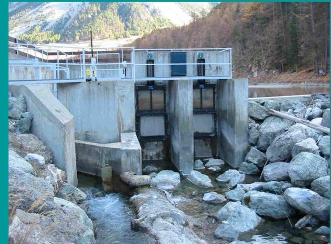
Recharge sédimentaire en aval par curage de la retenue et réinjection
