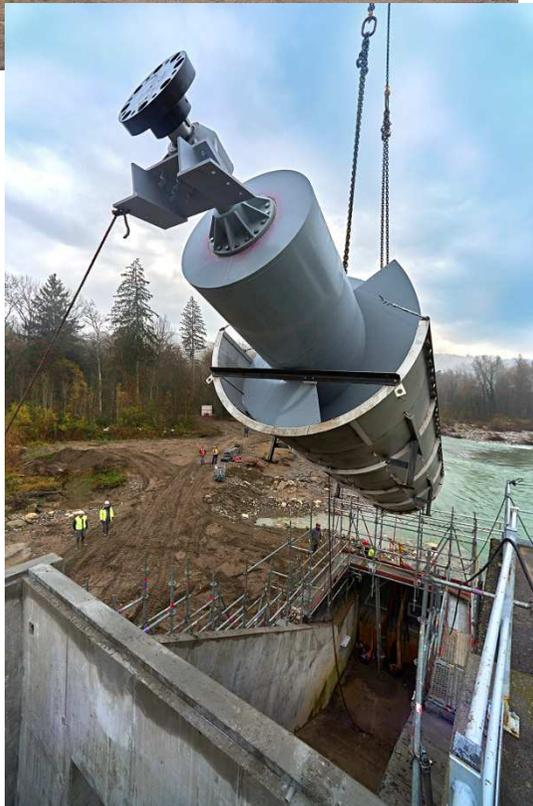
2ème phase de travaux de fin novembre 2016 à janvier 2017 : livraison et mise en place de la vis et ses équipements, béton de scellement, raccordement électrique et serrurerie
