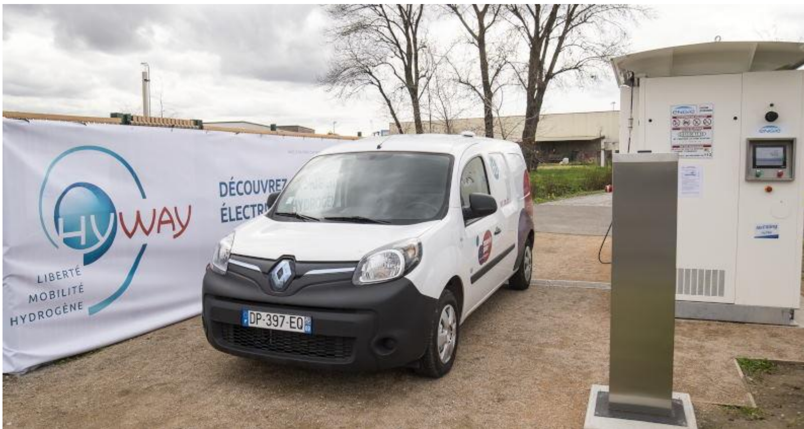
Station du Port de Lyon
