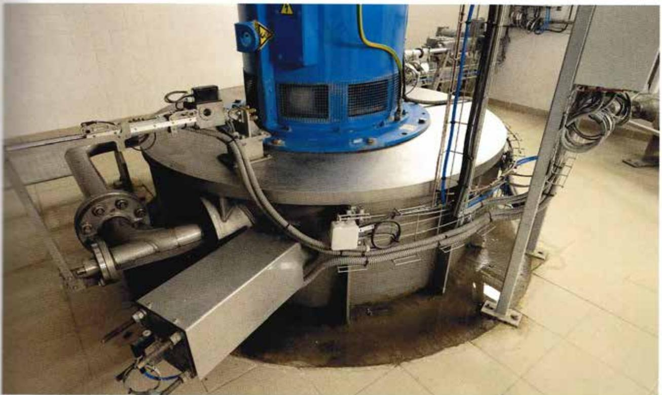
▲ Le vérin électrique du système PEP de la turbine de Chapareillan (Isère) se trouve en haut à gauche et le "muscle" pneumatique au-dessous dans le carter. Photo : Berti Hanna
