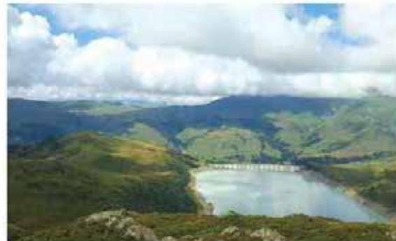
Construit entre 1942 et 1949, le barrage savoyard de la Giroto, profond de 134 mètres (50 millions de m<sup>3</sup> d'eau retenue), alimente sept centrales électriques.
