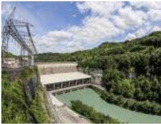
Le barrage hydroélectrique de Génissiat dans l'Ain. Photo d'illustration Le DL/Norbert FALCO
