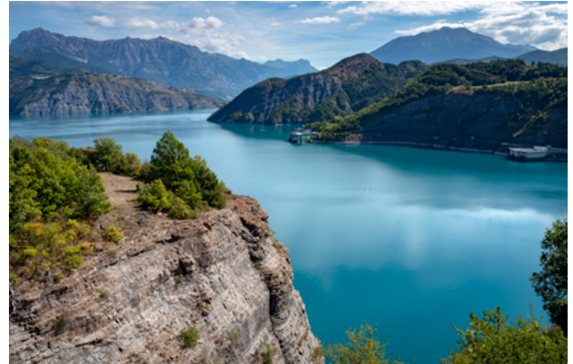
© Barrage de Serre Ponçon - EDF - Popy Xavier
