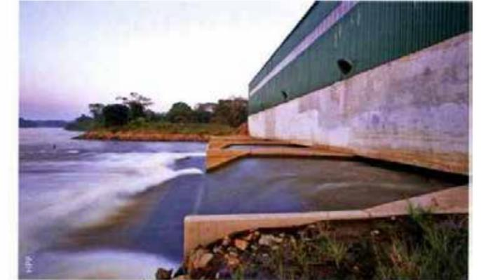
Centrale hydraulique de 21,6 MW (quatre turbines Francis de 5,4 MW) installée par HPP en République démocratique du Congo en 2014.
