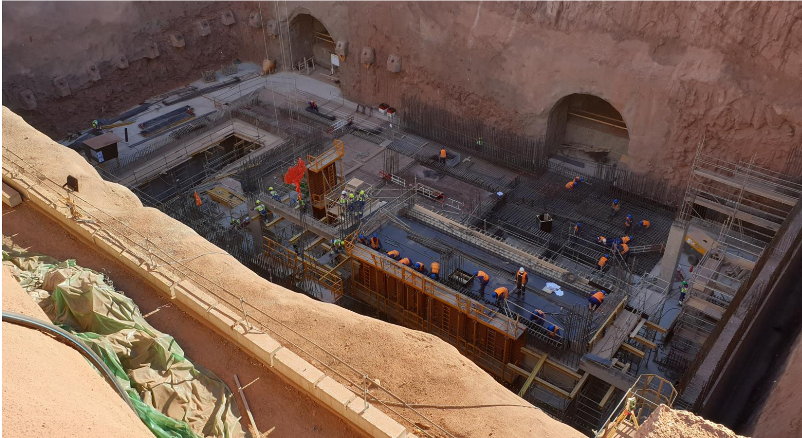
Fondation de l'usine en puits – janvier 2020 (photo VCGP)
