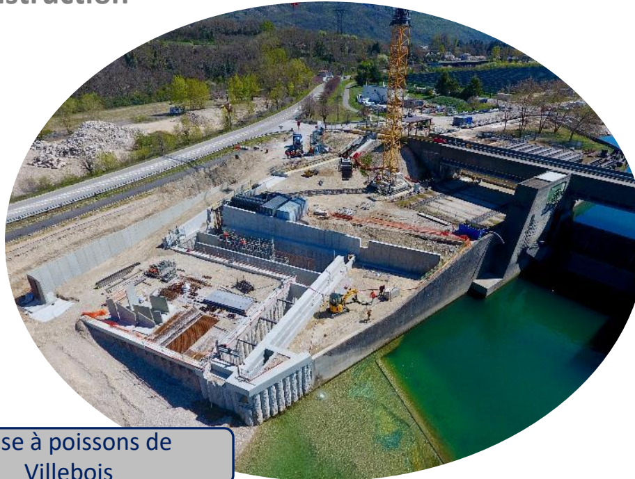
Confortement de l'aval barrage de Donzère
